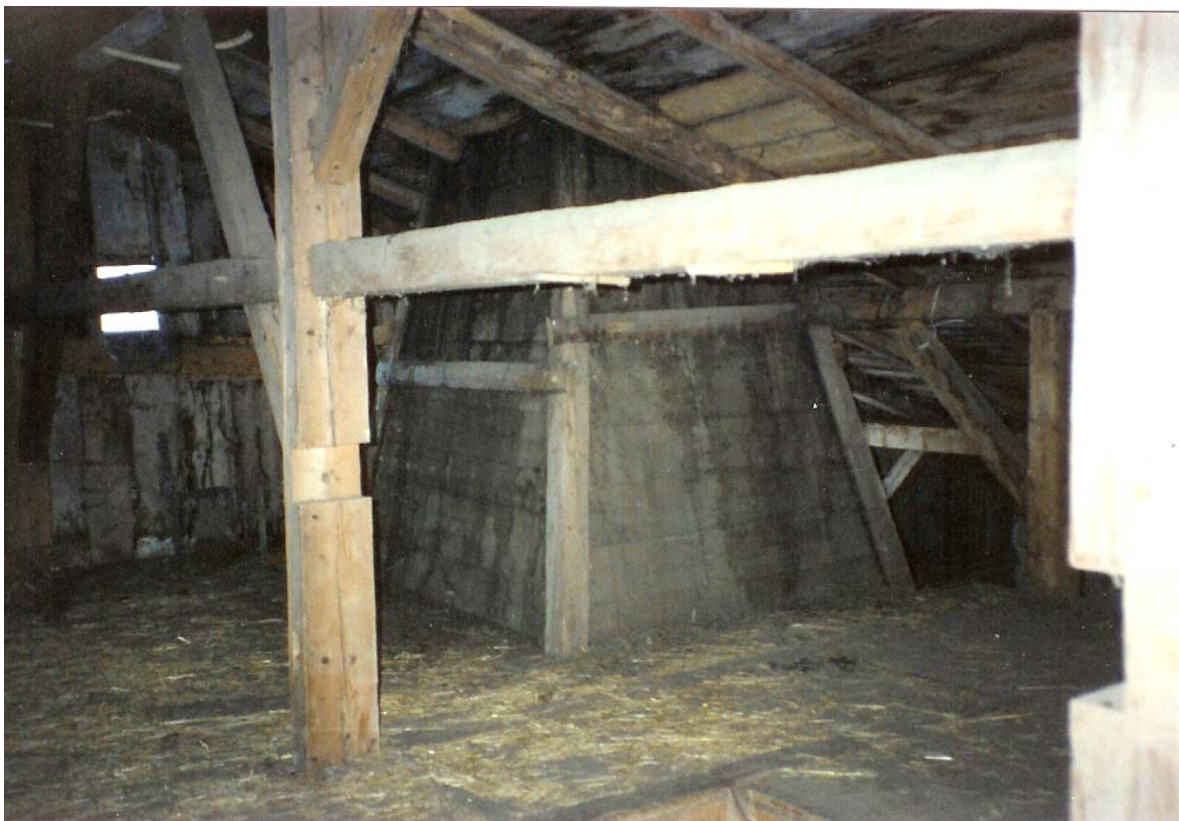
Extérieur d'une cheminée de bois dans une ancienne ferme de la commune du Lieu. Il vaudrait mieux que la cheminée n'ait pas de trou !
