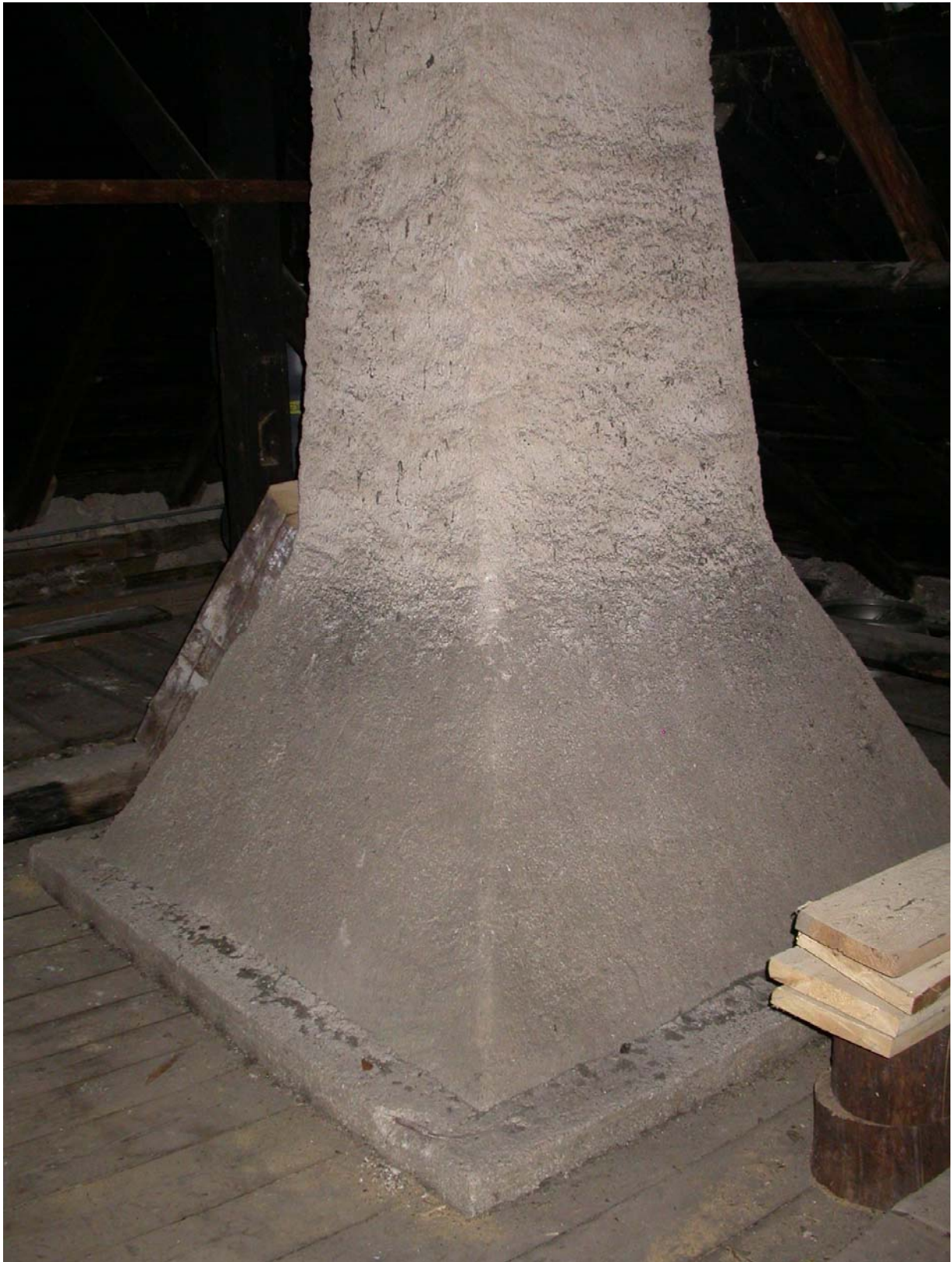
Cheminée en dur à Mallevaux-dessus. Le poids en est terrible, vu que pour monter au niveau du toit et même dépasser celui-ci de plus d'un mètre, son canal devra être de six ou sept mètres !
